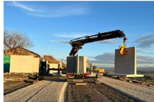
Abb. 1 Versetzen der Elemente
